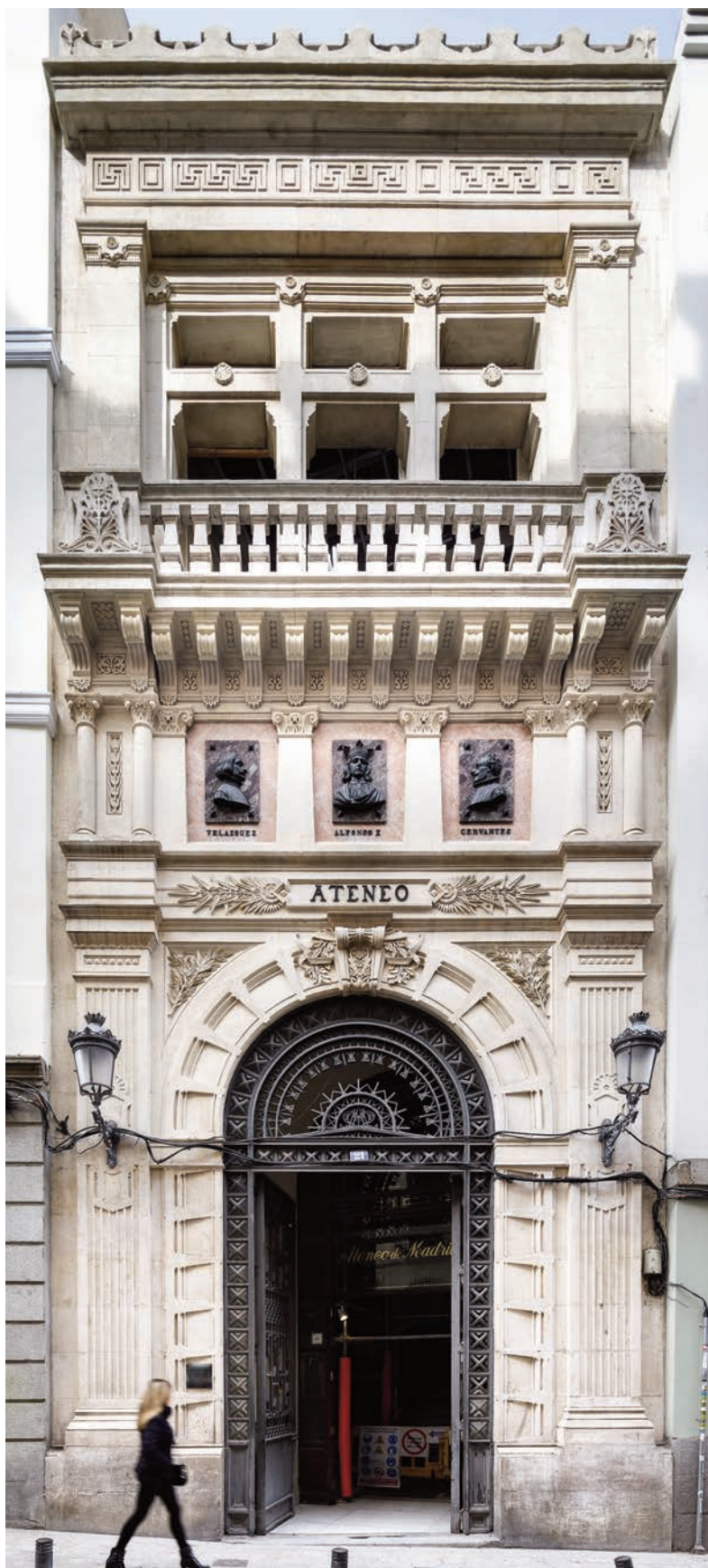
► Fachada principal de la calle Prado, 21.
